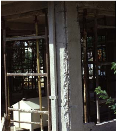
Φωτ. 1 (αρ.): Αποφλοίωση σκυροδέματος επικάλυψης Φωτ. 2,3 (μέσο & δεξ.): Ανεπαρκής αγκύρωση πάνω & κάτω ράβδων δοκού
