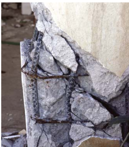
Φωτ. 12,13 (αρ. & μέσο): Άνοιγμα συνδετήρων με κάμψη άκρων κατά 90° μετά την αποφλοίωση της επικάλυψης των οπλισμών Φωτ. 14 (δεξ.): Εκτίναξη γωνίας διατομής σκυροδέματος λόγω μη συγκράτησης του κατακόρυφου οπλισμού στη γωνία συνδετήρα
