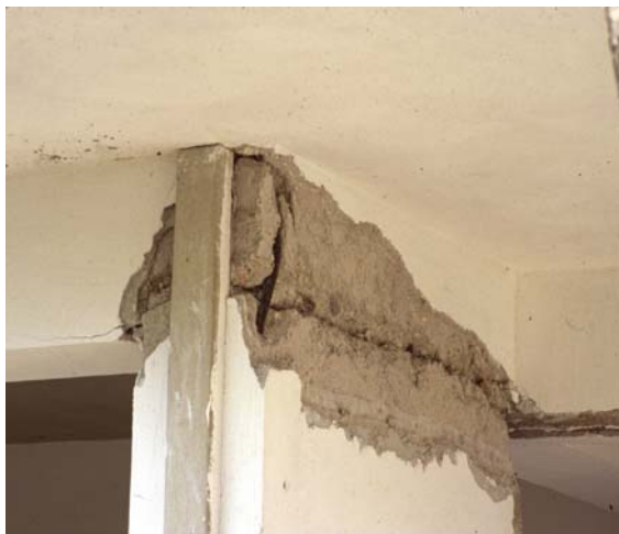
Φωτ. 4 (αρ.): Ανεπαρκής αγκύρωση κάτω ράβδων δοκού λόγω σκυροδέτησης υποστυλώματος πάνω από τη μασχάλη δοκού Φωτ. 5 (δεξ.): Διάρρηξη απερίσφιγτου σκυροδέματος κόμβου (Fib Bulletin 24)
