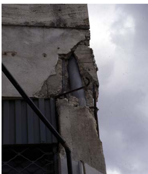
Φωτ. 23 (αρ.): Αστοχία κόμβου και απώλεια περίσφιγξης συνδετήρων λόγω τοποθέτησης υδρορροής εντός του υποστυλώματος
