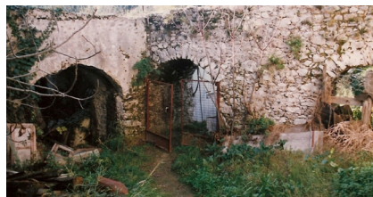
Το τοξωτό κανάλι μεταφοράς του νερού
